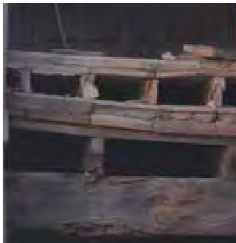
*Los revoltones de los forjados se construían con bóveda de una hoja tabicada recibida con yeso y se rellenaban por el trasdós con yeso hasta enrasarlo con el lomo de las viguetas, salvo en buhardillas, donde se rellenaban eventualmente con arena.*
