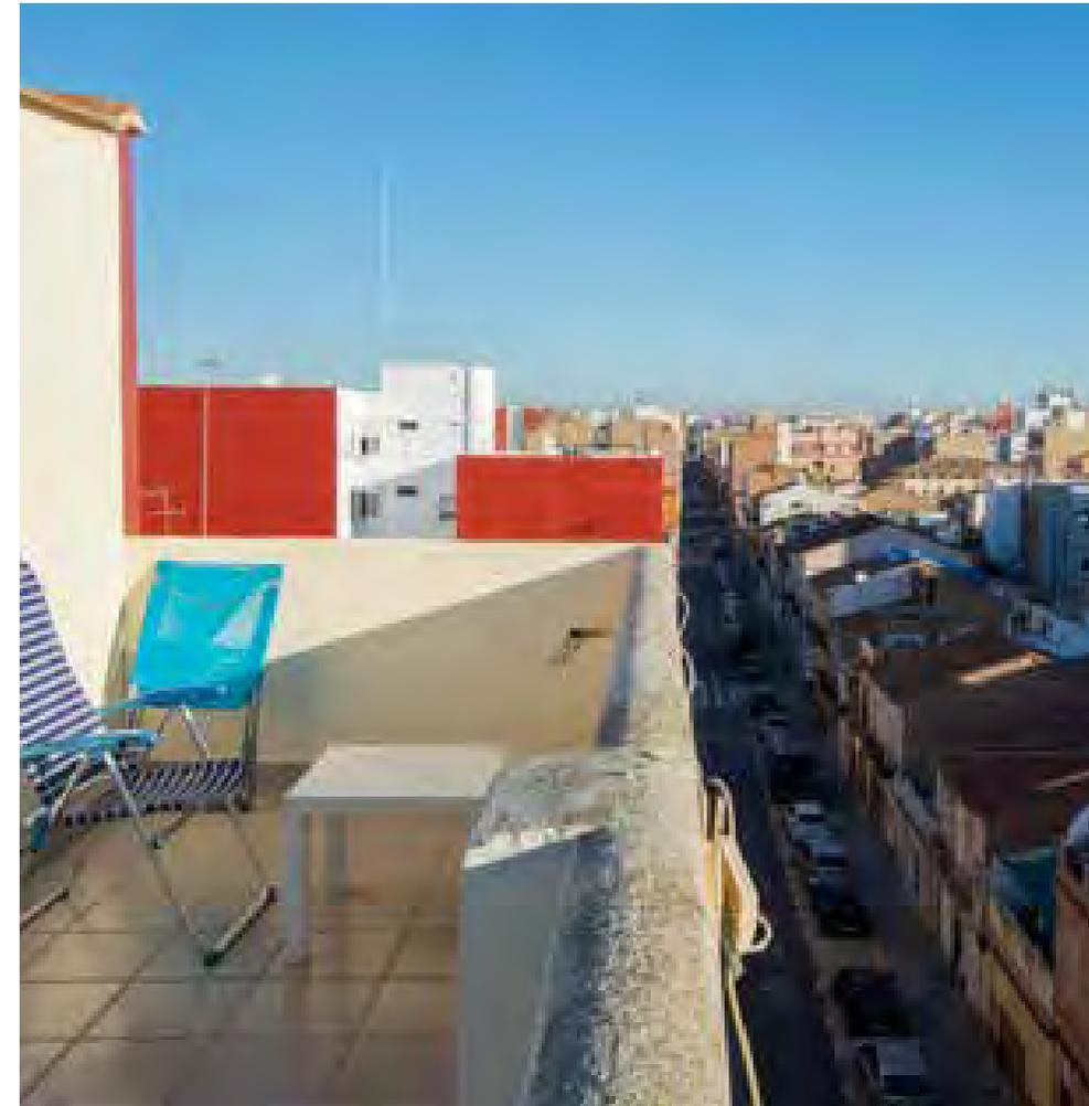
*En las azoteas, el frente de fachada se resuelve entre machones con las tradicionales barandillas de forja o fundición (Amparo Guillén 4), balaustradas o antepechos ciegos, mixtos o calados de cerámicas o prefabricadas.*
