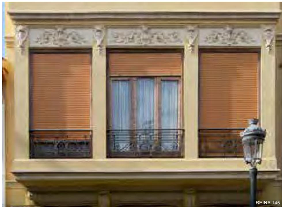
Los miradores desempeñan una extraordinaria función de control climático, además del rol de extender el espacio habitable. Cerrados, permiten la penetración de la radiación solar, e incluso crean un espacio intermedio de aislamiento y transición entre interior y exterior, pero impiden la entrada del viento desagradable. Abiertos, en cambio desempeñan la misma función de ventilación e iluminación de las ventanas de la casa.
