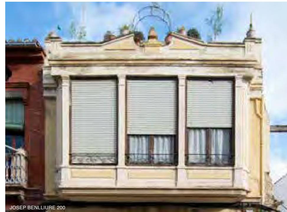
Las hojas acristaladas de un mirador son normalmente practicables. En la mayor parte de ellos se extienden desde el rodapié hasta el techo, en modo que se combinan con parapetos bajos de forja, fundición, piedra artificial calada u obra. Con la arquitectura racionalista estos parapetos bajos evolucionarían a paños fijos acristalados, antepechos ciegos o pasamanos horizontales de barras de acero cilíndricas.
