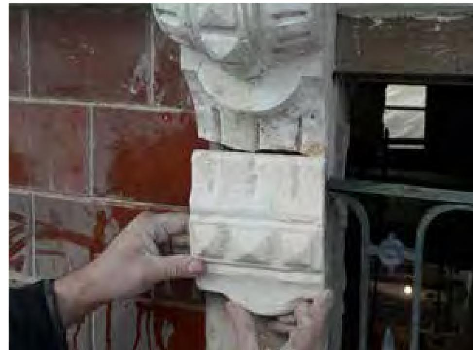
fabricadas con molde y adheridas con el mismo yeso se fabrican de forma similar, con una pieza siempre con el mismo material a partir de una matriz que se recibe en el muro con ayuda de yeso.
