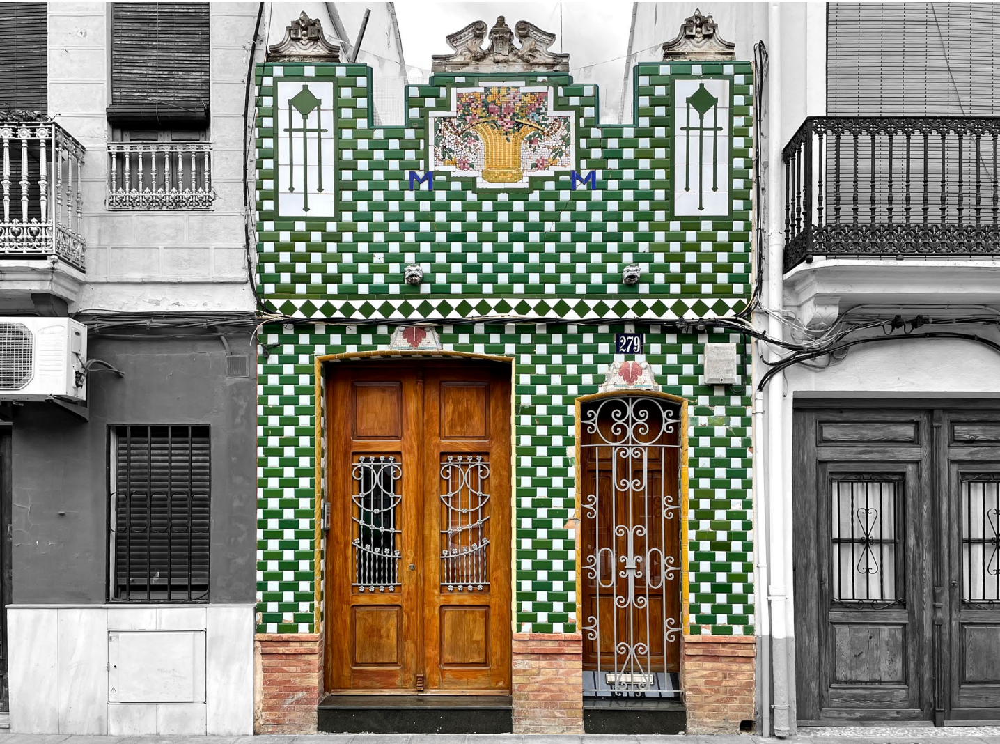
Fachada cerámica de estilo modernista C/ del Progrés nº279
